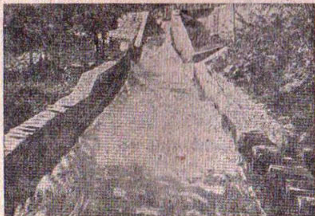
Рис. 12. Быстроток: вид сверху вниз.
