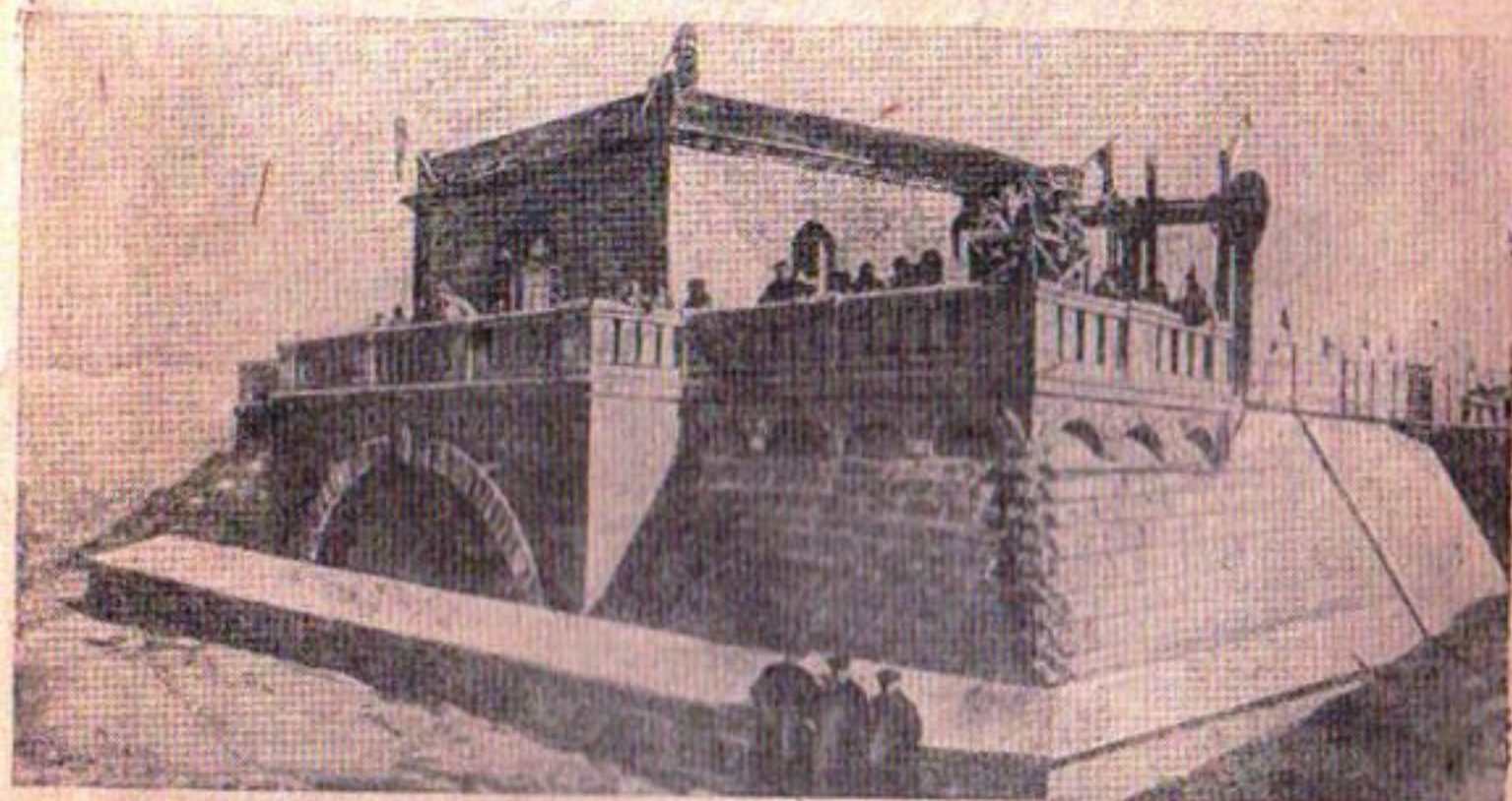
Рис. 9. Вид на бассейн и напорные камеры снизу.
