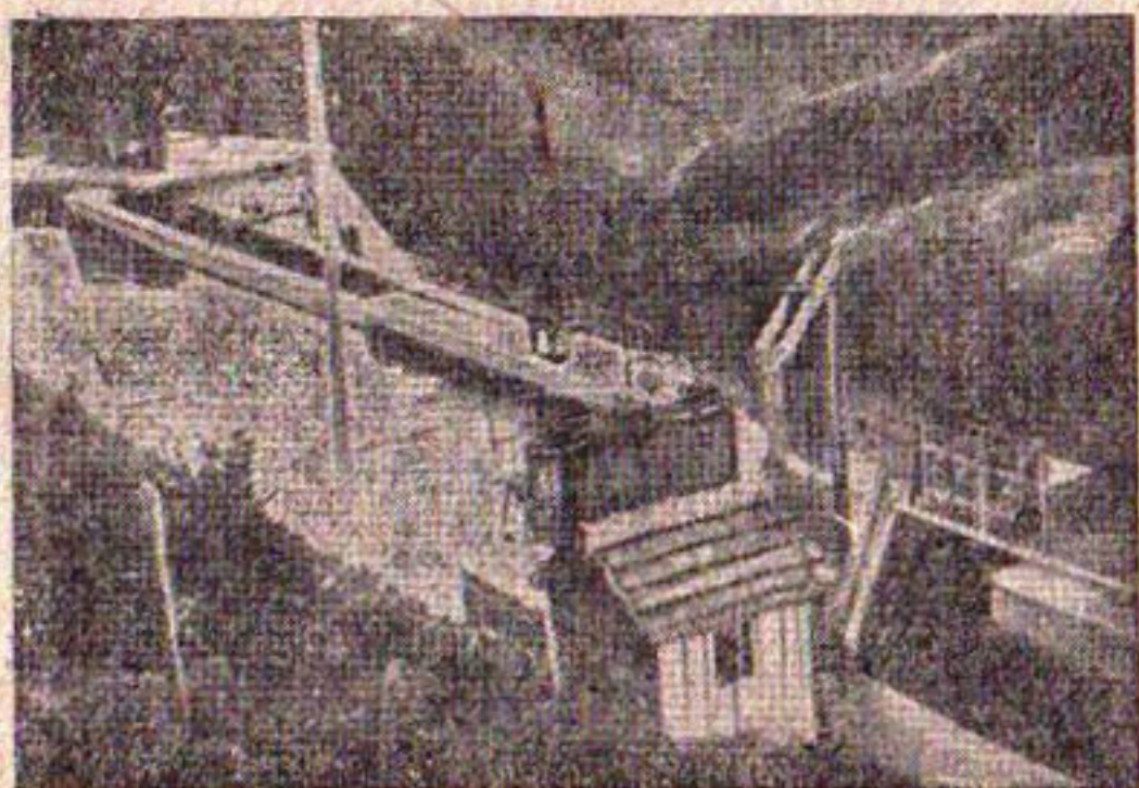
Рис. 4. Напорный и отстойный бассейн.
