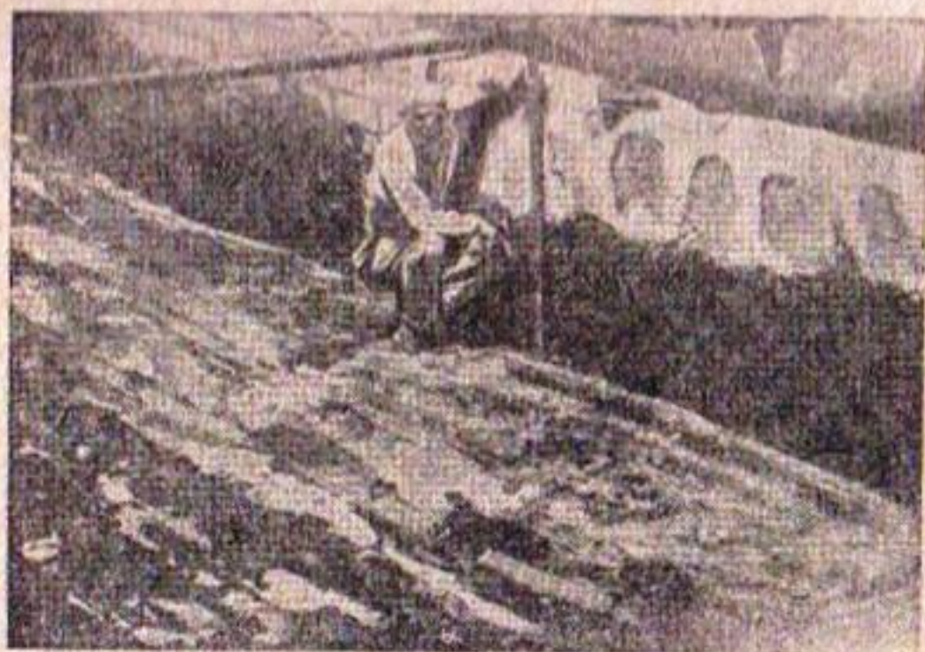
Рис. 10. Дно и стенки быстротока.
