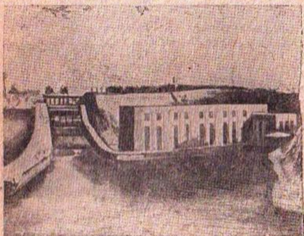
Рис. 25. Общий вид станции.
