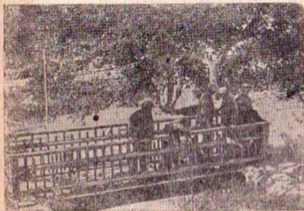
Рис. 24. Измерение скоростей трубкой Пито на поперечи № 13.
