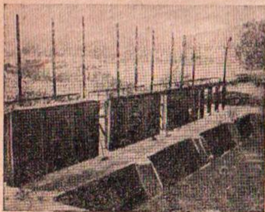
Рис. 16. Щитовые затворы.
