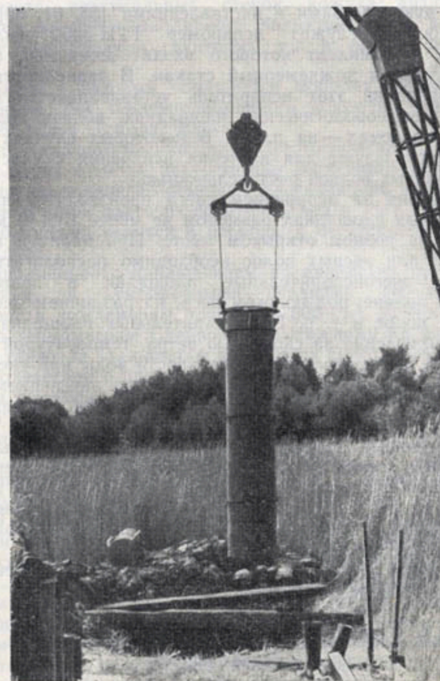
Рис. 20. Зарядка 2-5-метрового монолита лизиметра ГР-80.
