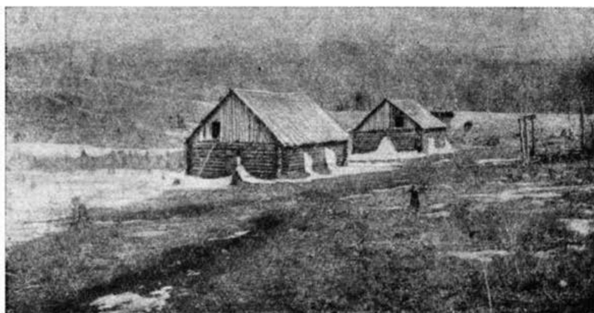
Рис. 206: Наледная вода, проникшая в здание и замерзшая в нем, частью вылившись из окон и дверей.
