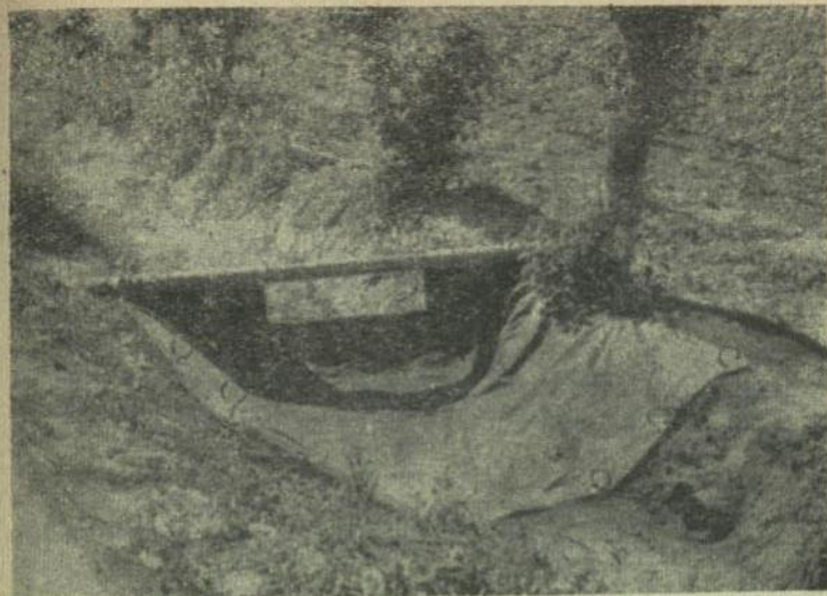
Рис. 10. Установка переносной перемычки на участковом распределителе.
