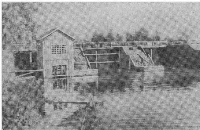
Рис. 2. Деревянная плотина на реке Вытегре
