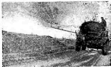
Рис 32. Нанесение мелкорантов с помощью прицепного битумовоза БКР-1, оборудованного титановым и дугообразным распылителем
