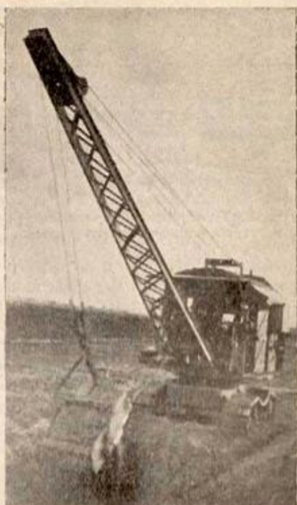
Рис. 11. Гусеничный экскаватор фирмы „Marion“ с газелиновой машиной. Емкость ковша 1 куб. ярд. Экскаватор роет распределитель шириною по дну 1 метр на оросительной системе „Imperial Valley“ в Калифорнии.
