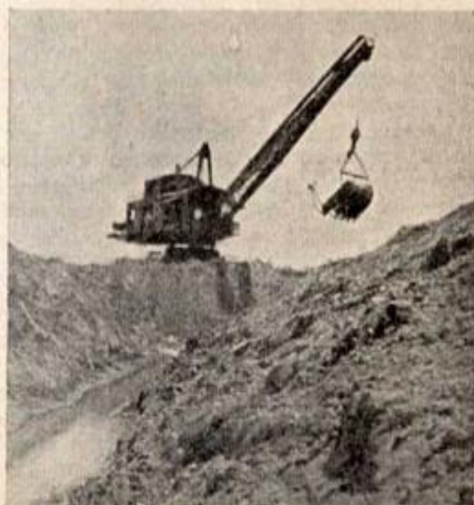
Рис. 19. Экскаватор „Бьюсайрус“ на дренажном канале на системе Imperial Valley в Калифорнии.
