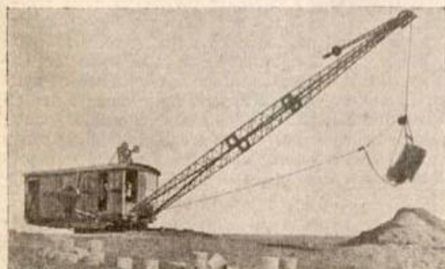
Рис. 12. Экскаватор фирмы „Monaghan“ на дренажных работах в штате Миннесота. Емкость черпака 1 куб. ярд. Длина стрелы 40 футов. Машина внутреннего сгорания.
