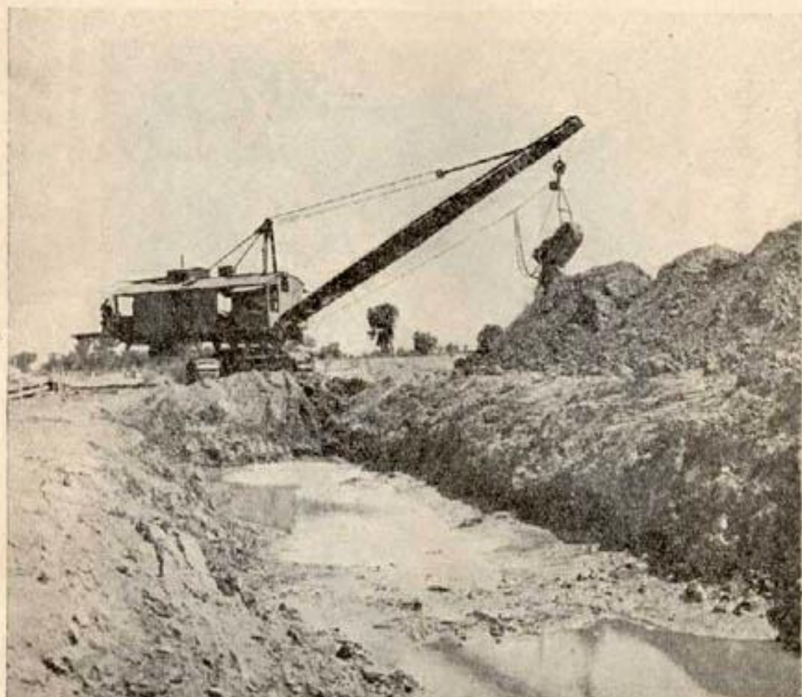
Рис. 9. Гусеничный экскаватор фирмы «Бьюсайрус» с черпаком емкостью 2 куб. ярда, работающий по устройству главных дренажных каналов на оросительной системе Юма в штате Аризона.
