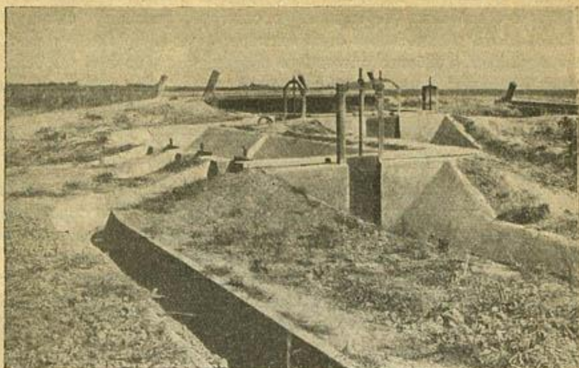
Подпорное сооружение и водомерный ящик в голове участка № 3.
