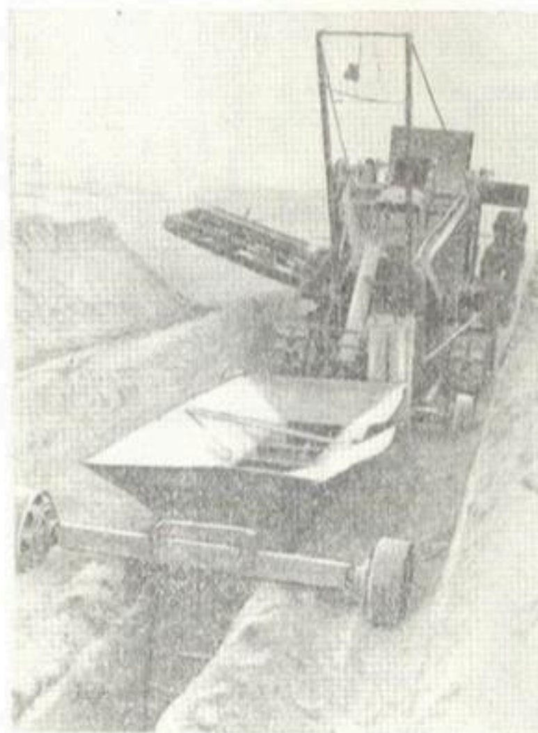
Рис. 3. Дренопрокладчик Д-251 в работе.
