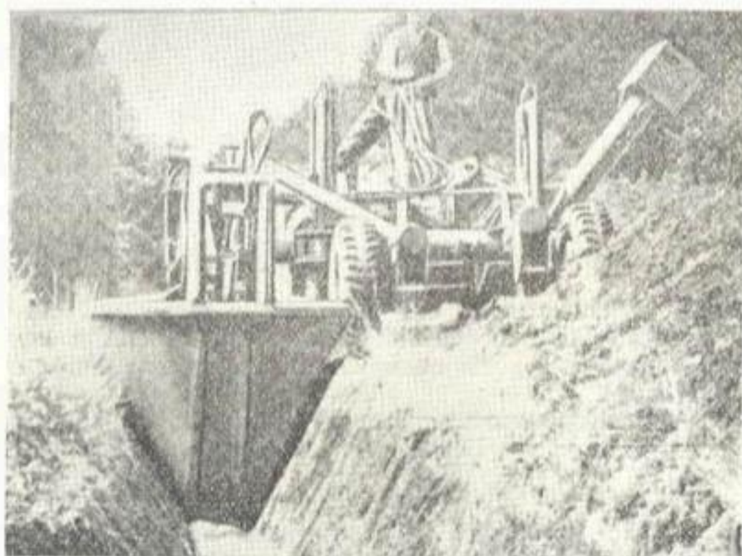
Рис. 7. Каналоочиститель с двухстворчатым ковшом во время работы.
