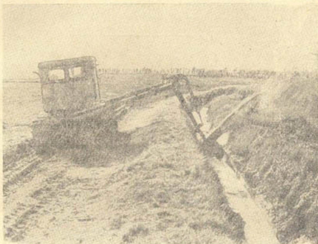
Рис. 1. Каналоочиститель Д-342А в работе.
