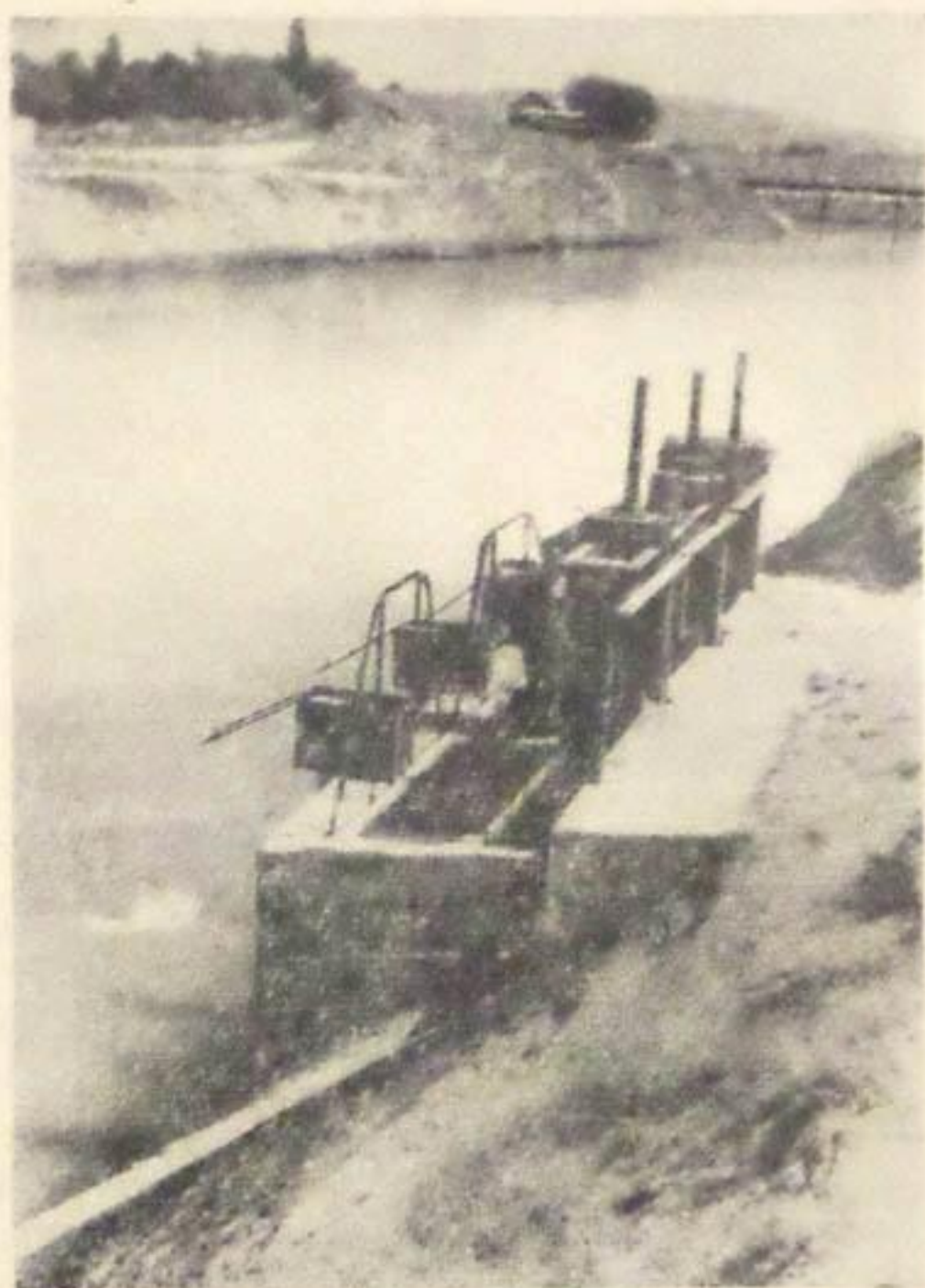
Рис. 2. Реконструированный водомер-регулятор на Большом Гиссарском канале.
