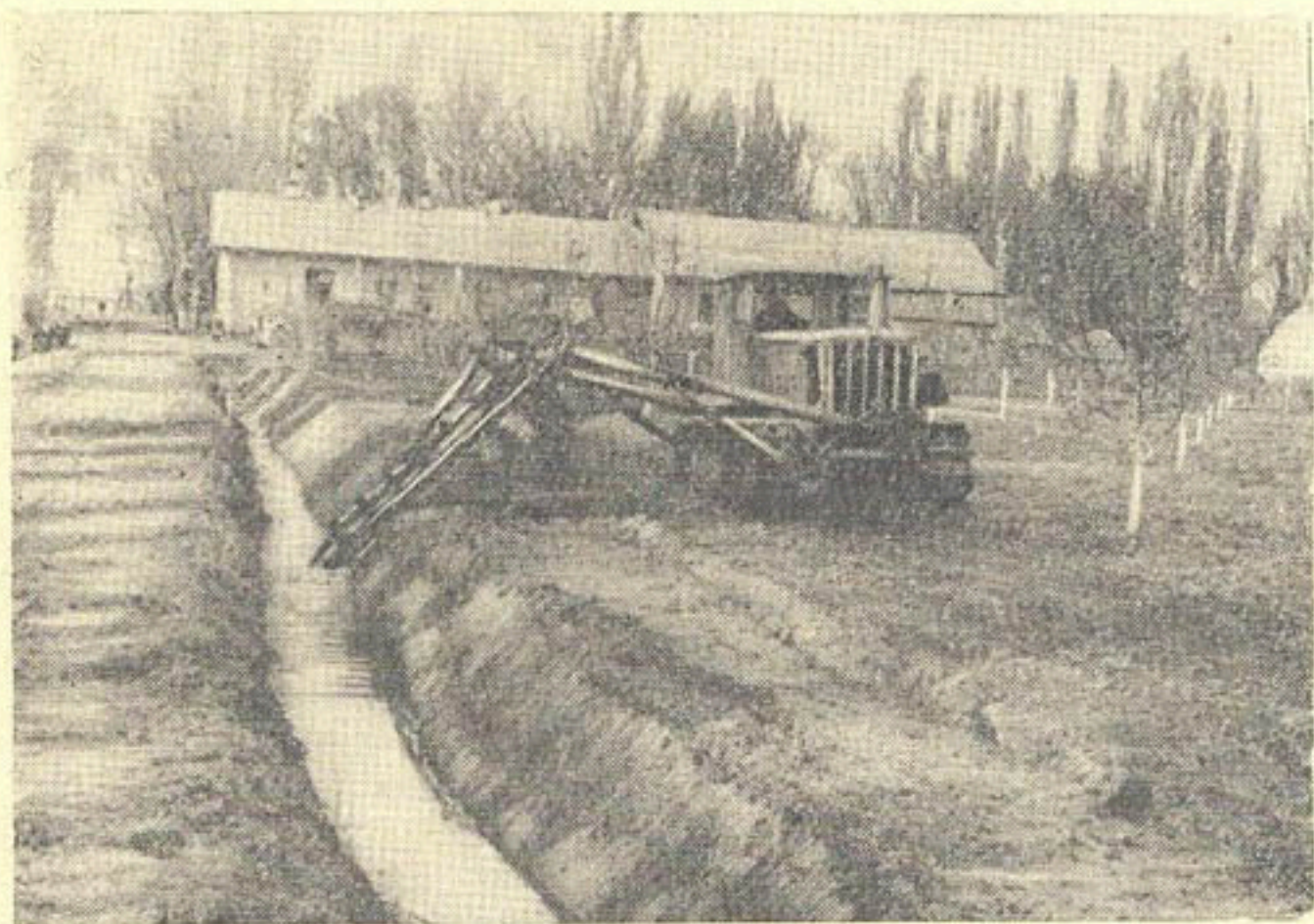
Рис. 3. Каналоочиститель Д-342А со скребковым оборудованием в работе.
