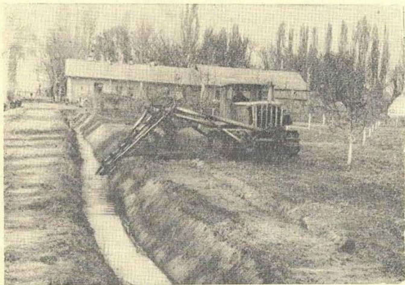
Рис. 3. Каналоочиститель Д-342А со скребковым оборудованием в работе.
