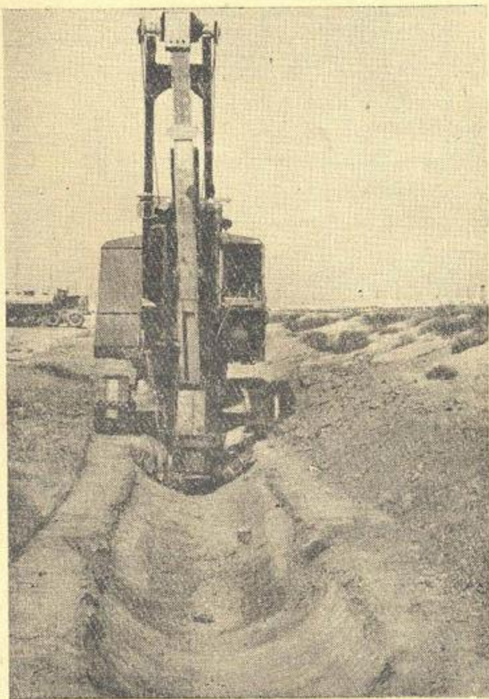
Рис. 2. Вид трамбовочного агрегата во время работы.
