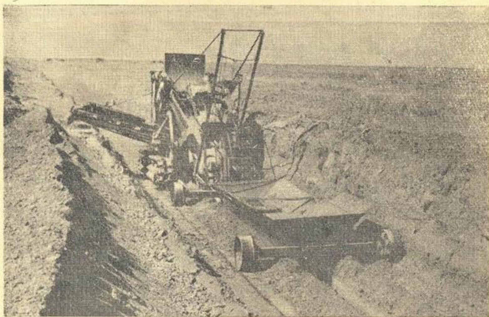
Рис. 1. Дреноукладочный комбайн на строительстве закрытого дренажа в Голодной степи.
