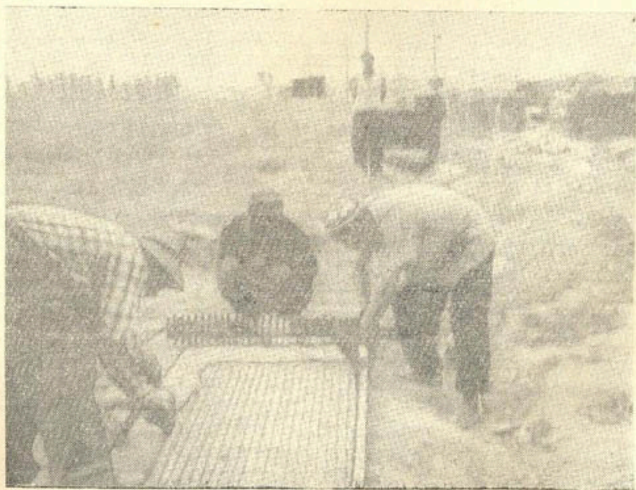
Рис. 4. Нарезка лент при помощи дискового ножа.
