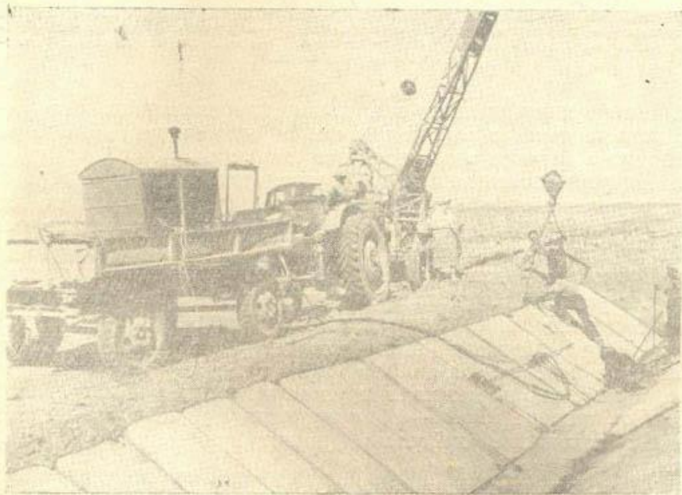
Рис. 3. Комплексный монтажный агрегат для монтажа сборных облицовок каналов с обжатыми швами.
