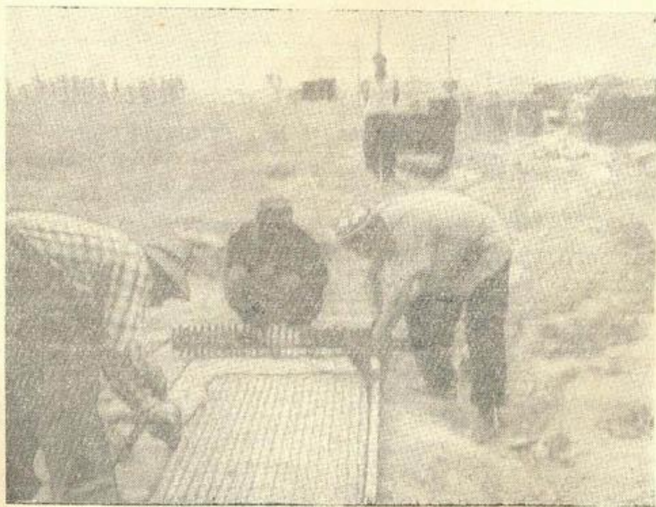
Рис. 4. Нарезка лент при помощи дискового ножа.
