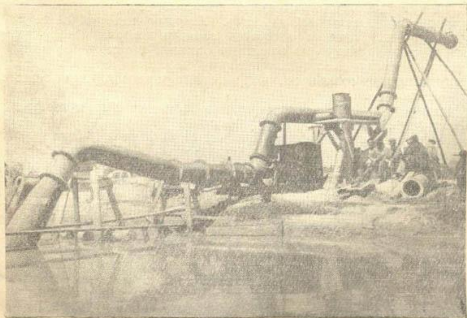
Рис. 13. Испытание насосного агрегата ПГ-35×2 с приподнятым коленом всасывающей трубы вместо пускового вакуумнасоса (1954 г.)
