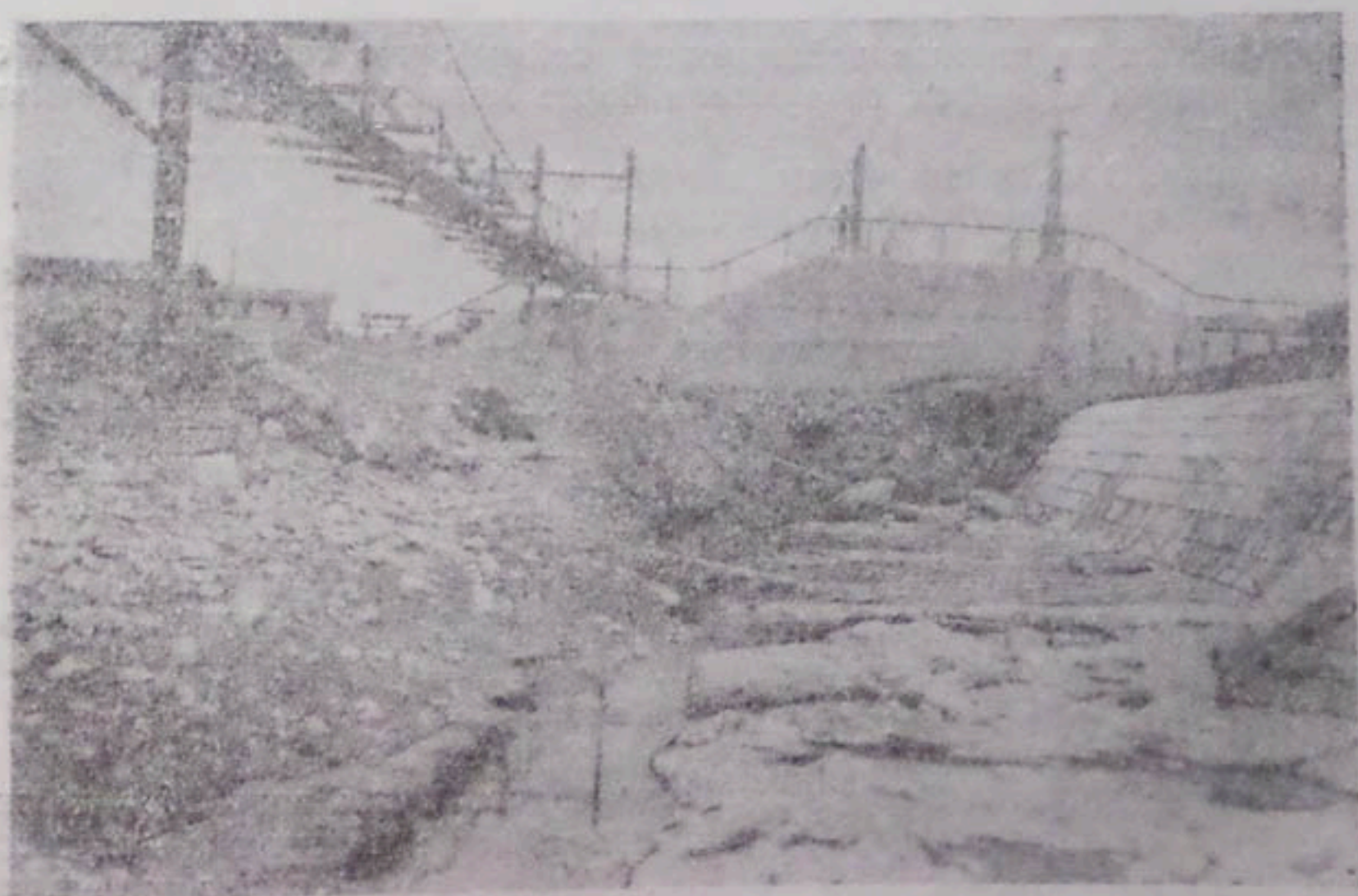
Рис. 18. Занесение нижнего бьефа у правой стороны водослива.
