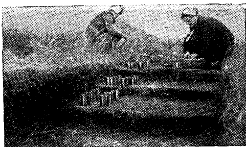
Рис. 26. Определение водопроницаемости почвы дифференциальным методом трубок:
