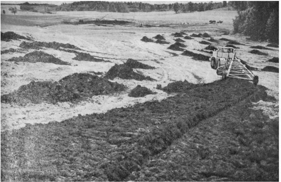
Рис. 2. После капитальной планировки обнаженный грунт рекультивируется торфованием (фото Я. Талберга)
