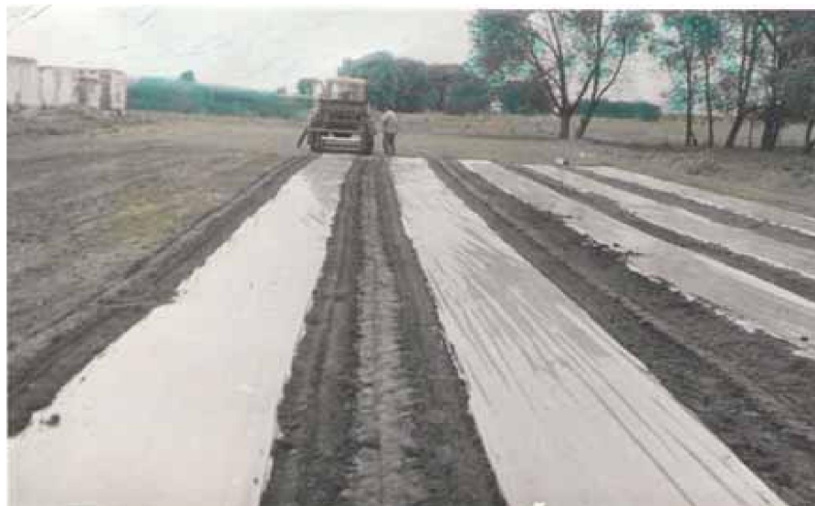
Фото 3 Механизированная укладка полиэтиленовой пленки
