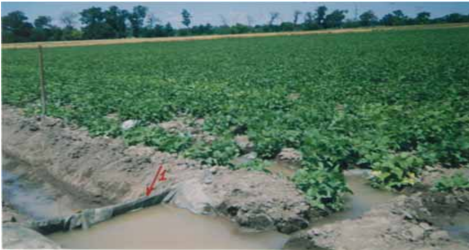
Фото 7. Гибкий перегораживающий подпорный щит – регулятор расхода воды
