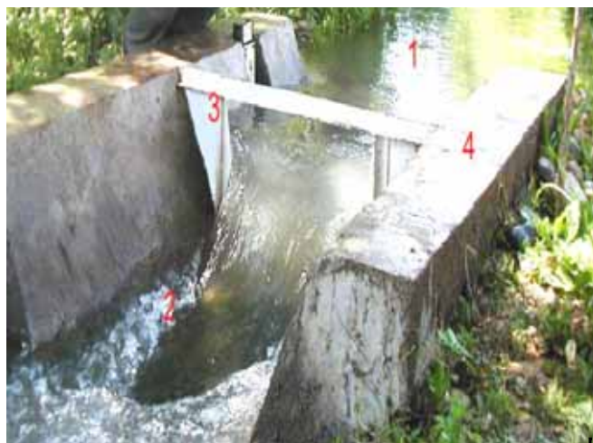
Рис. 3.2. Водослив Чиполетти (вид с нижнего бьефа): 1- подводящий участок; 2-отводящий участок; 3-водослив;
