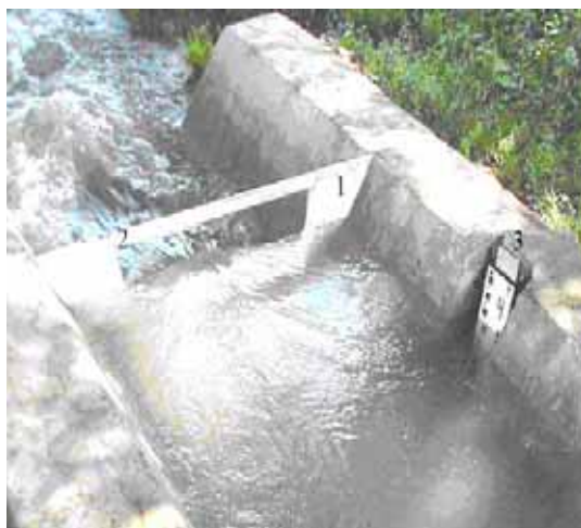
Рис. 3.1. Водослив Чиполетти (вид с верхнего бьефа):
