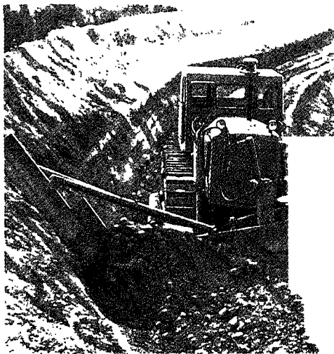
Строительство террас буль- дозером с откосником
