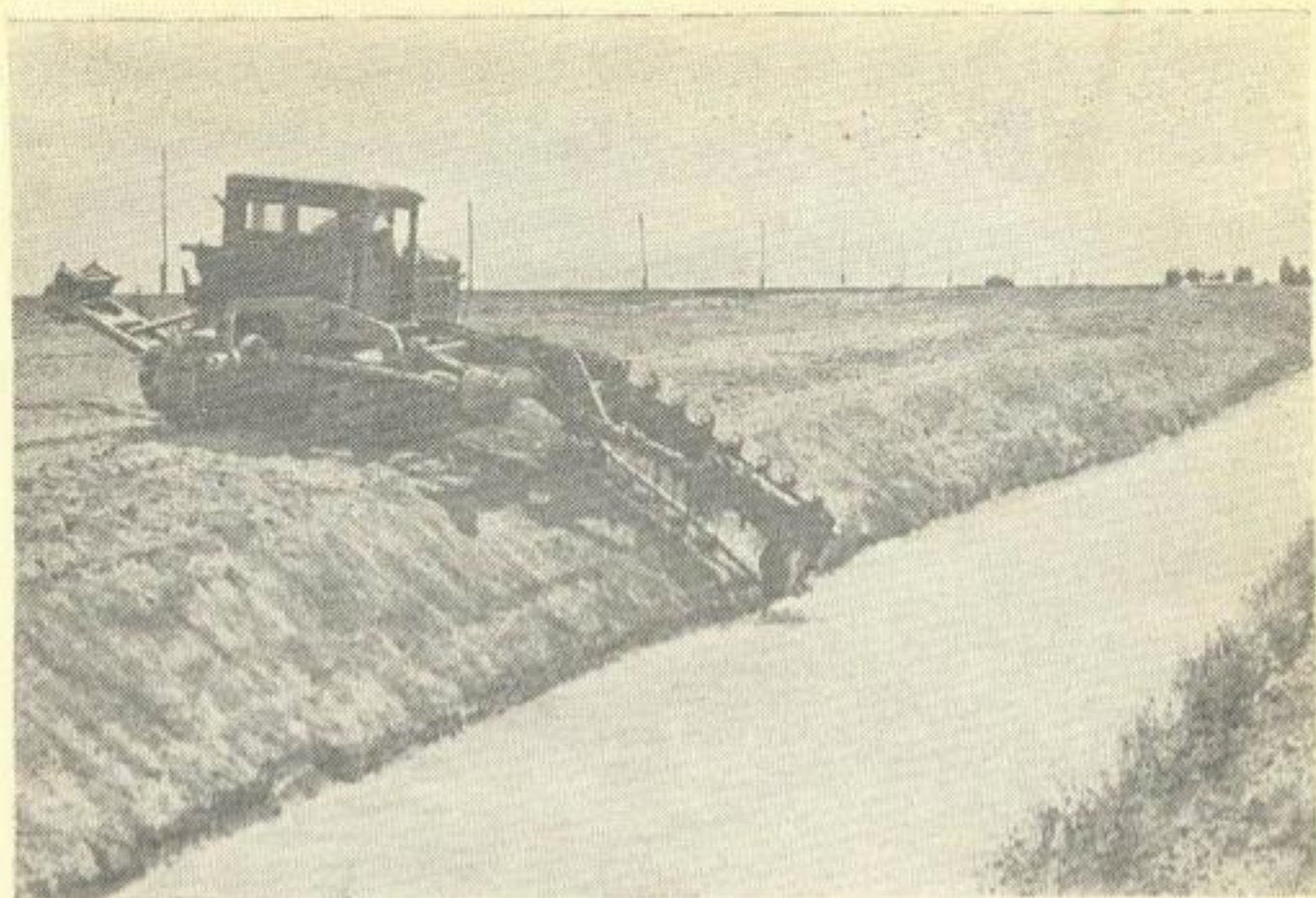
Рис. 14. Каналоочиститель Д-490 в работе (Варваровская оросительная система).
