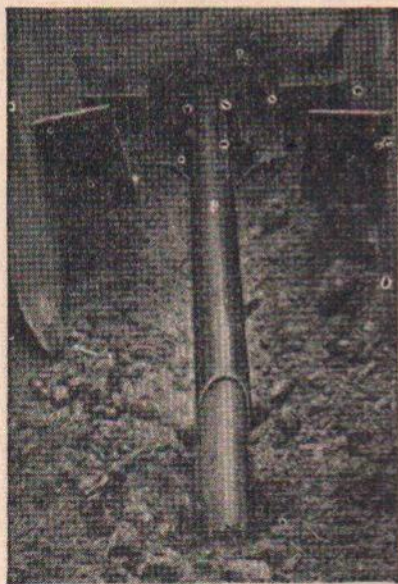
3 Пластмассовая дренажная труба, обернутая стеклохолстом, в момент выхода из формующей трубы
