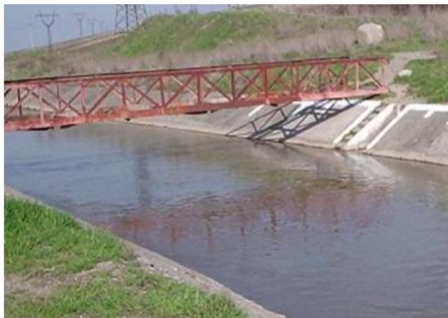
Рисунок 2 – Гидрометрический створ в фиксированном русле открытого канала, Республика Узбекистан 6
