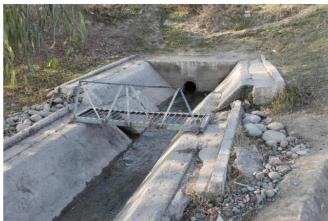
Рисунок 3 – Гидропост типа «фиксированное русло» на сбросе в р. Араван-Сай, Киргизская Республика 7
