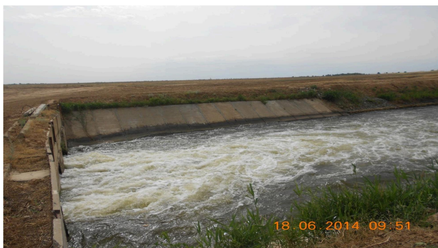
Рисунок 3 – Общий вид гидрометрического створа на ПК 243 + 80
