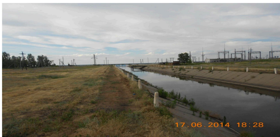
Рисунок 2 – Общий вид гидрометрического створа на ПК 243 + 80
