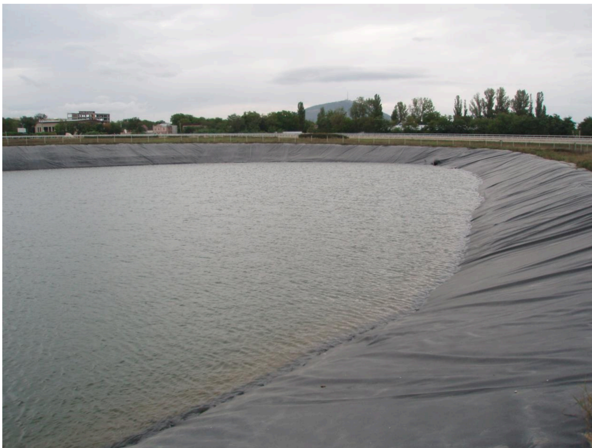
Рисунок 2 –Водоем-накопитель с поверхностным противофильтрационным экраном из геомембраны
