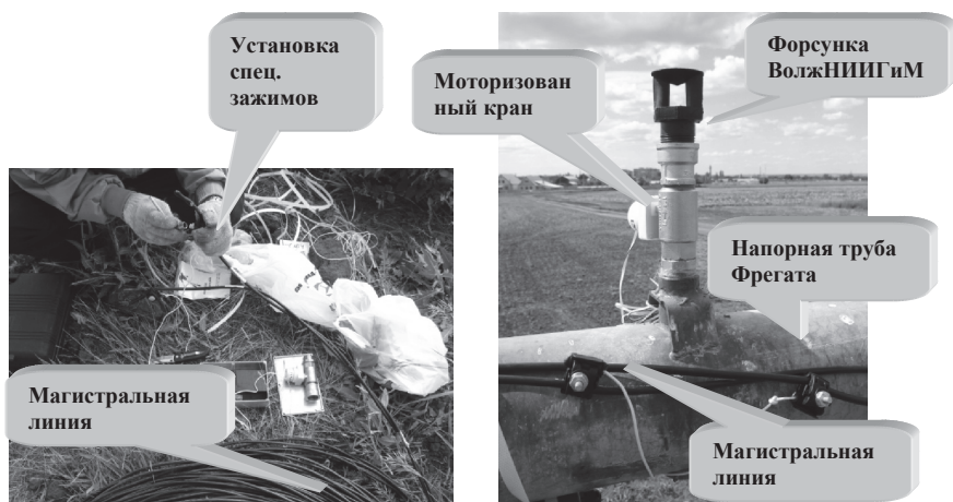
Подключенный к магистральной линии моторизованный кран.
