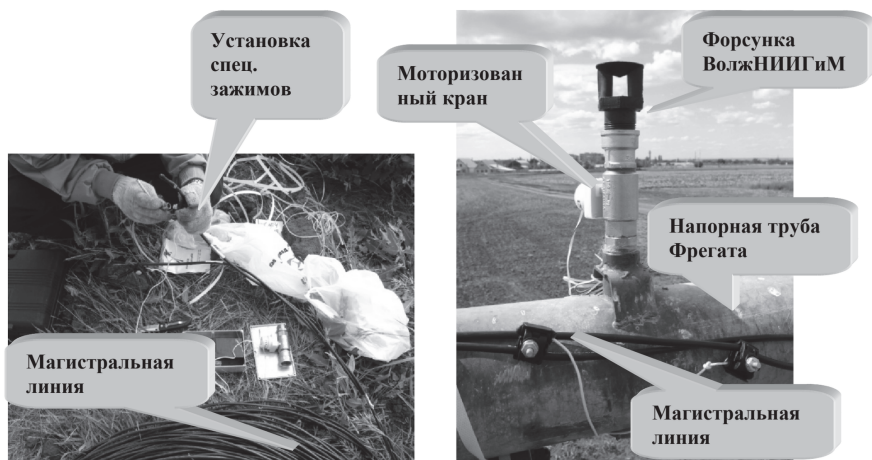
Подключенный к магистральной линии моторизованный кран.
