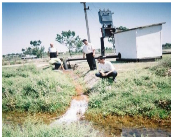
Рисунок 2 – Подача воды из скважины вертикального дренажа в участковый ороситель
