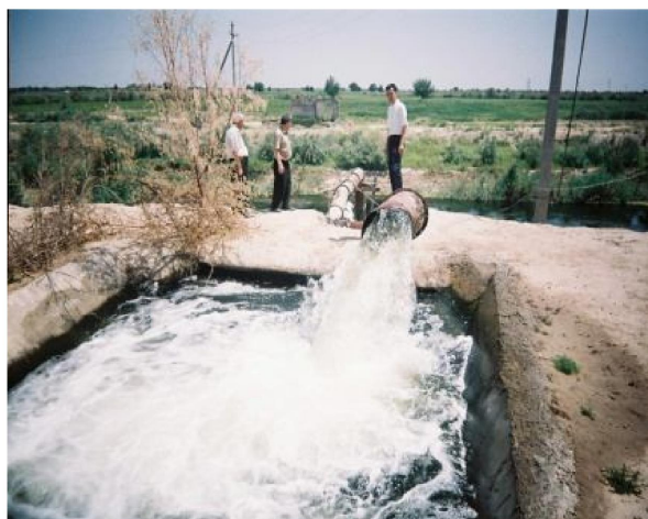
Рисунок 1 – Забор коллекторно-дренажных вод из коллектора Шурузяк
