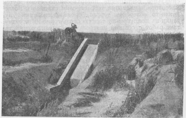
17. Вершинное овраго-укрепительное сооружение (каменно-бетонный быстроток).
