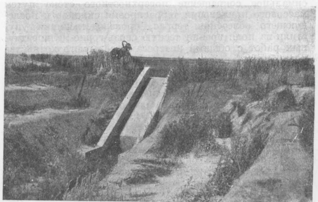
17. Вершинное овраго-укрепительное сооружение (каменно-бетонный быстроток).
