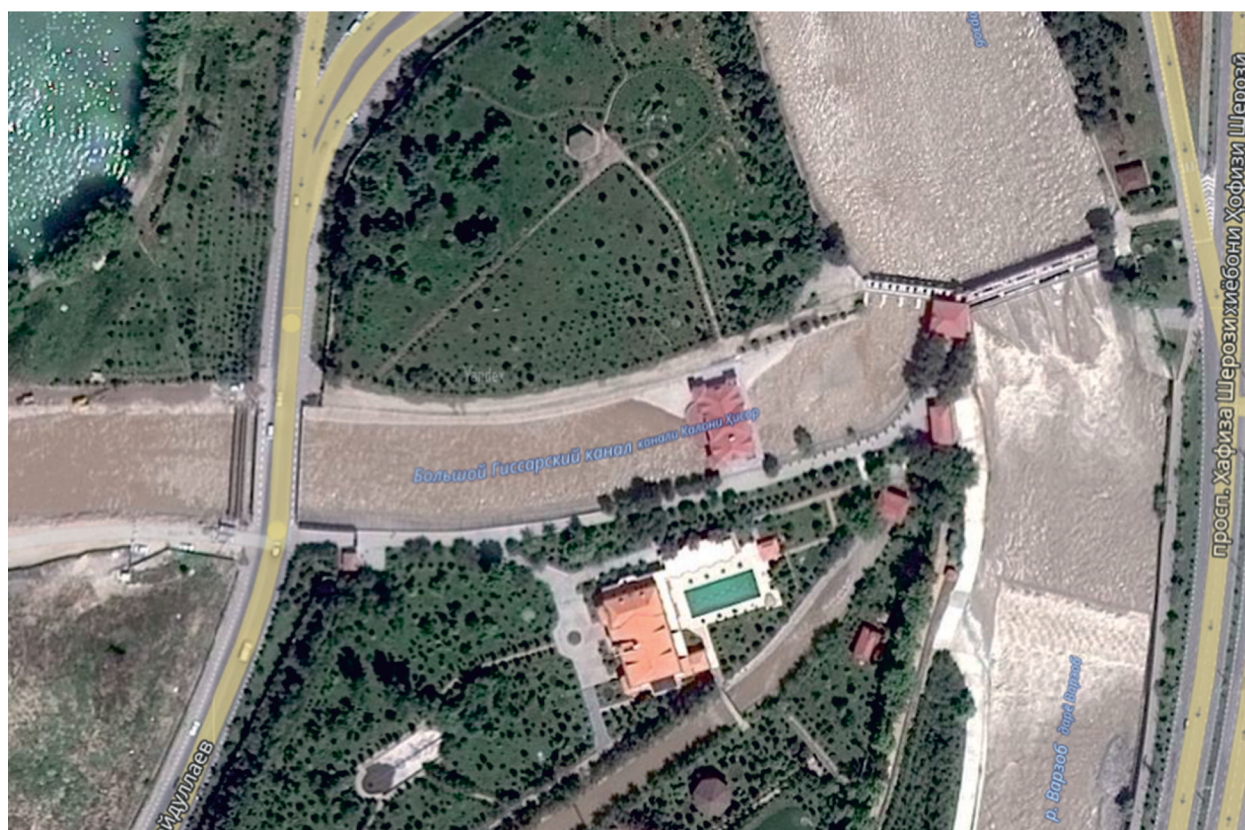
Рис. 1. Водозаборное сооружение БГК
