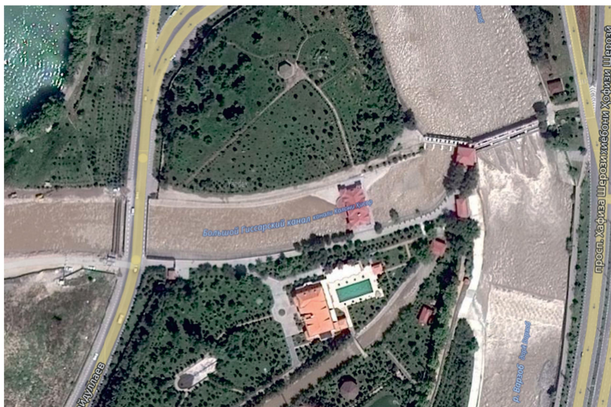
Рис. 1. Водозаборное сооружение БГК
