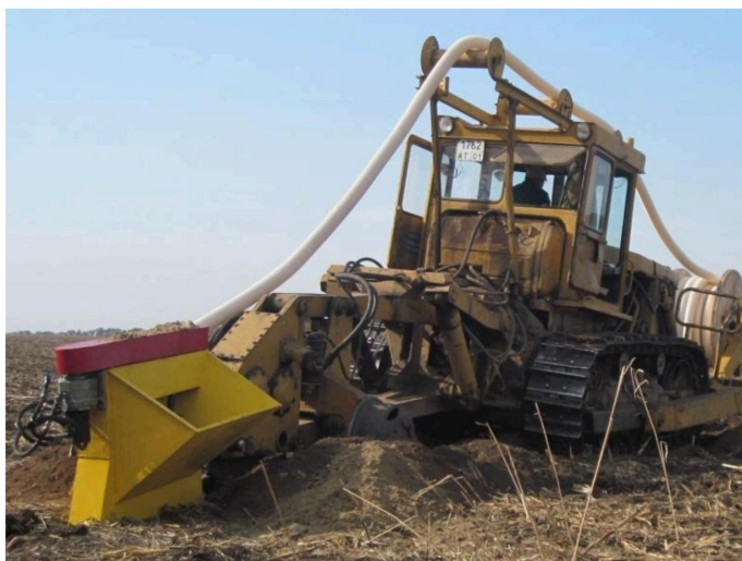
Рисунок 2 – Реконструкция дренажа ЗАО «Краснокутское»
