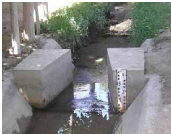
Рис. 6. Водомерный лоток САНИИРИ 1 – входные открылки, 2- гидротехническая рейка.
