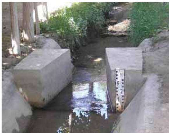
Рис. 6. Водомерный лоток САНИИРИ 1 – входные открылки, 2- гидротехническая рейка.
