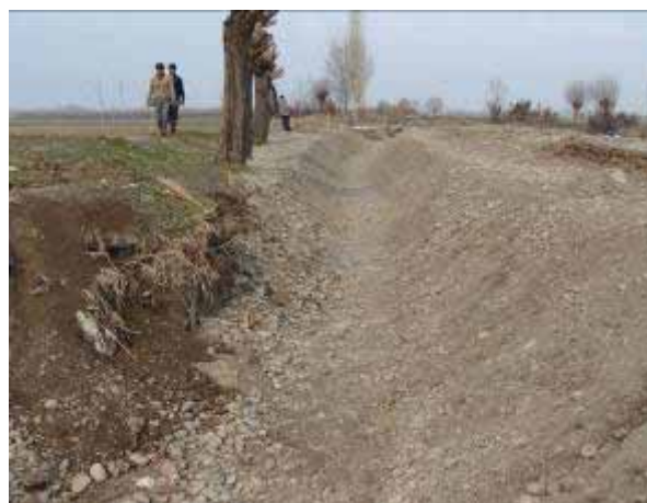
Прокладка проектного профиля в грунте
