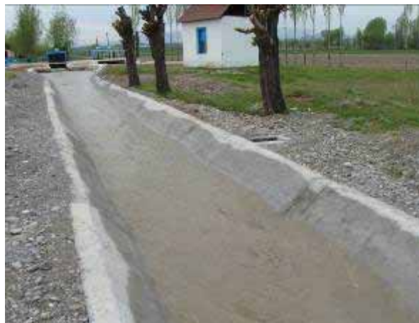
Створ гидропоста после реконструкции
