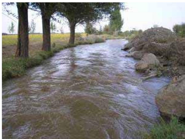
Головной участок канала "Конурат" до реконструкции
