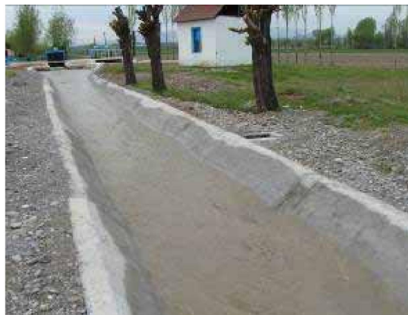
Створ гидропоста после реконструкции
