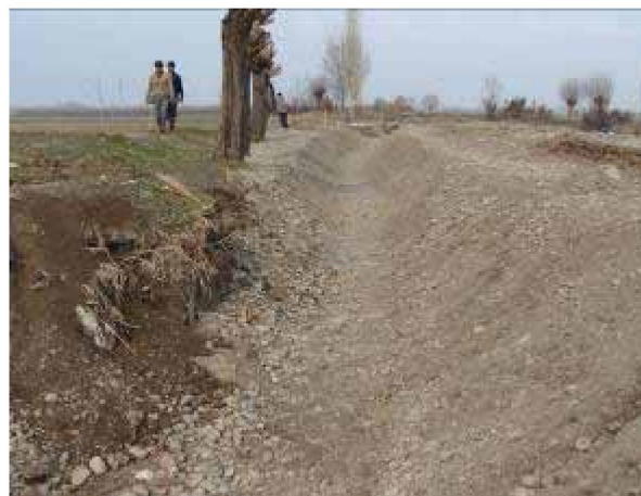
Прокладка проектного профиля в грунте
