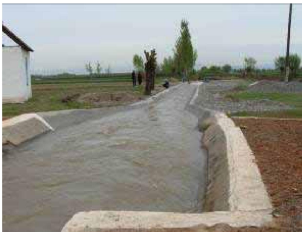
Завершенный головной участок канала
