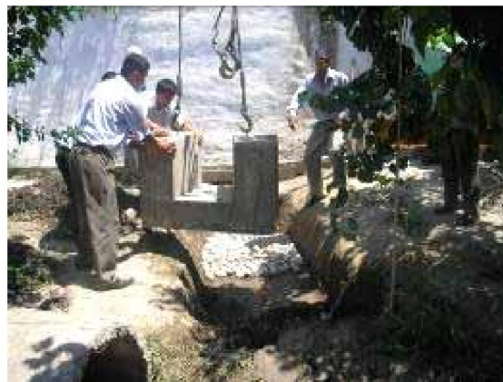
б) монтаж лотка ВЛС заводского изготовления
