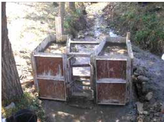
а) на месте при помощи переносной опалубки
