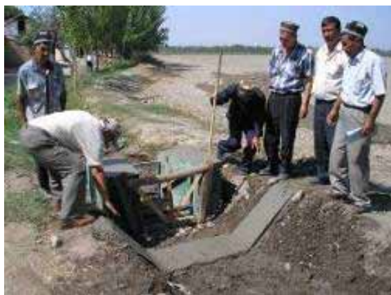
Рис 2. Обучение фермеров строительству гидропоста
