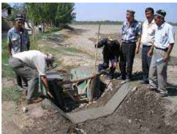
Рис 2. Обучение фермеров строительству гидропоста
