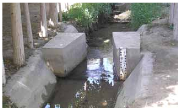
б) Гидропост с лотком САНИИРИ
