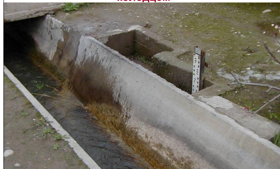
Гидрометрический пост типа «ФР» на параболическом лотке с уровнемерным колодцем
