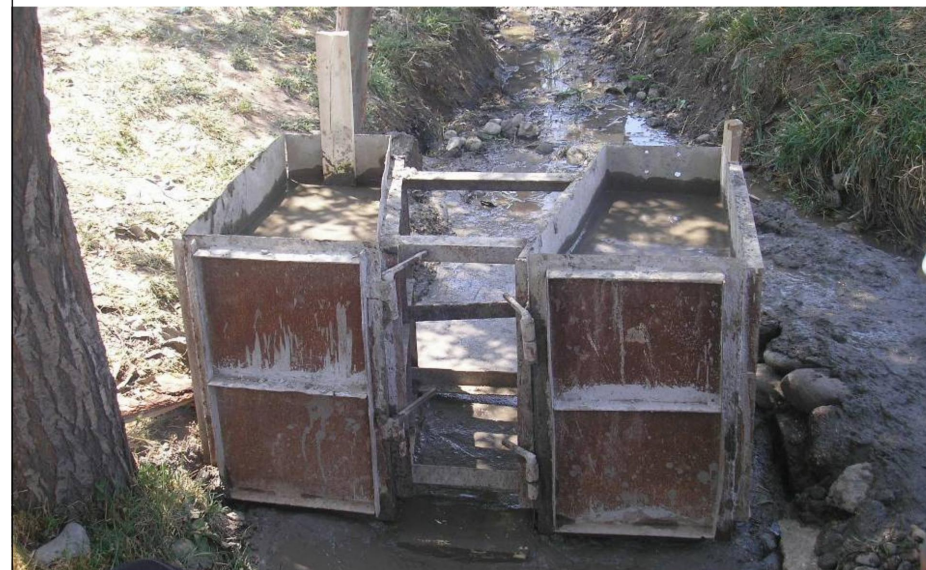
Заливка опалубки ВЛС бетоном на месте
