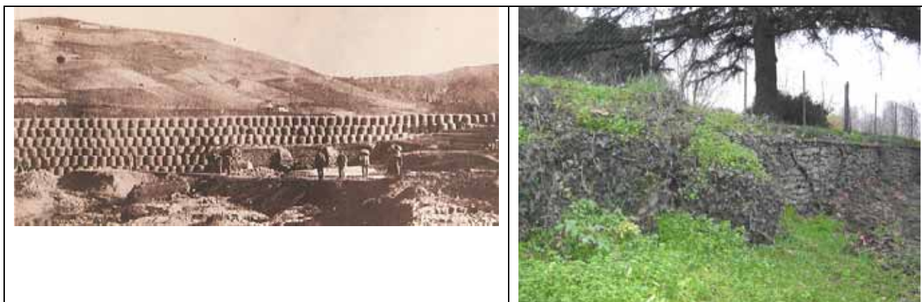
Рис. 1. Первый объект с использованием габионов
