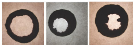
Рис. 1. Обрастание трубопроводов d = 40 мм различных лет эксплуатации
