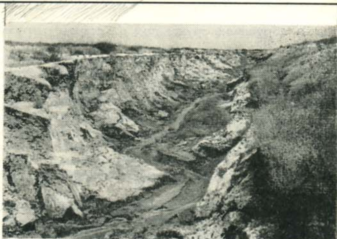
1 Обрушение коллектора
